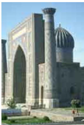
Fachada de la madrasa Shir-dar, Uzbekistán.
