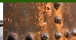
Corrosión u oxidación.
