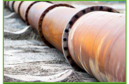
Las tuberías de hierro se oxidan por acción del aire.
