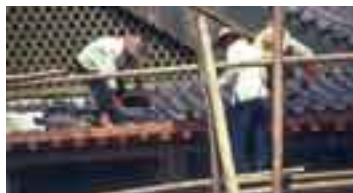
Paral de un andamio.
