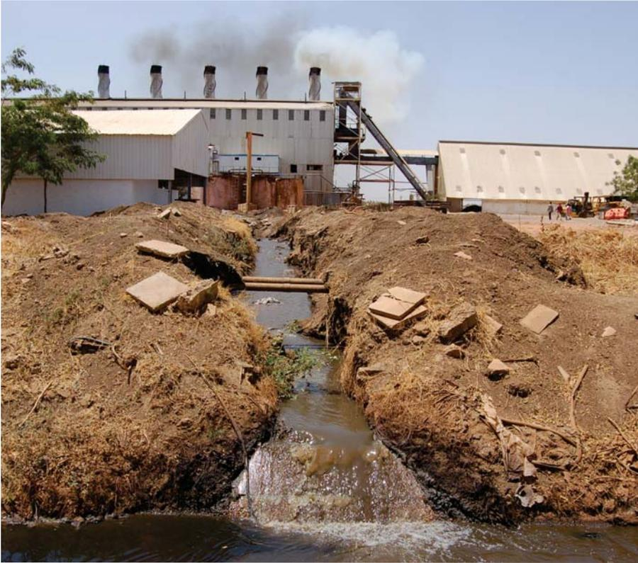
Usualmente, para enfriar las plantas de vapor termoeléctricas, se utilizan distintos métodos que contribuyen a regular la temperatura. Uno de los más utilizados consiste en tirar agua fría desde un cuerpo cercano de agua superficial. Luego se la hace pasar por medio de los condensadores de la planta y se la devuelve al mismo cuerpo de agua aunque con una temperatura más elevada.
