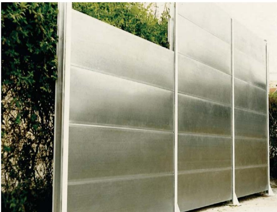
Otra forma de reducir este tipo de contaminación consiste en instalar pantallas o sistemas de protección entre el foco de ruido y los oyentes. Desde esta línea de trabajo ya se han puesto en práctica varias ideas, colocando pantallas a los lados de las autopistas o carreteras y o recubriendo con materiales aislantes las máquinas o lugares que son demasiado ruidosos.
