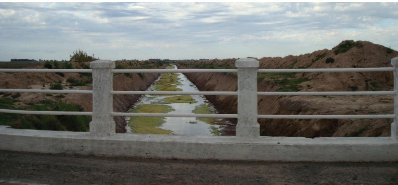
Puente de Juncal.
