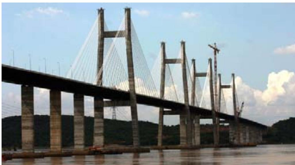
El Puente Orinoquia tiene una extensión de 3.156 metros, cuatro torres principales de 120 m de altura.
