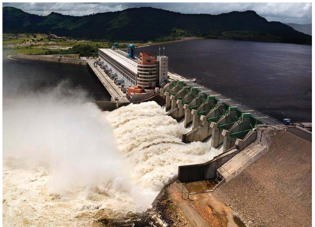
La Represa de Caruachi es un embalse de agua localizado a más de 60 kilómetros aguas abajo del Embalse de Guri, y 25 kilómetros aguas arriba del Embalse Macagua, en Venezuela. Fue inaugurada en el año 2006, y abarca un área de 250 km 2 . Aporta el 12% de la demanda eléctrica nacional. También se le conoce como la Central Hidroeléctrica Francisco de Miranda.
