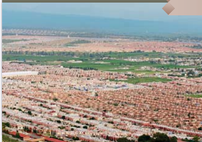
Construcción de viviendas en Ixtapaluca
