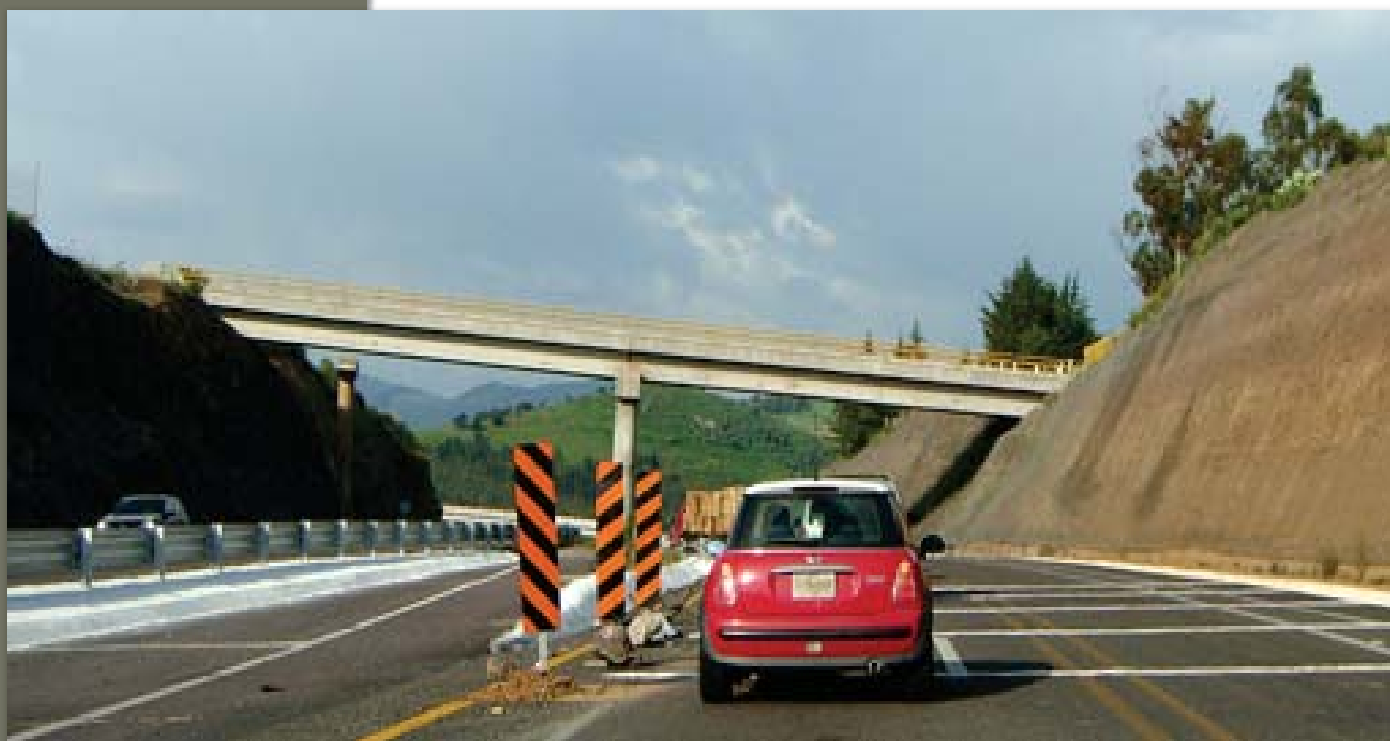
Carretera del Estado de México
