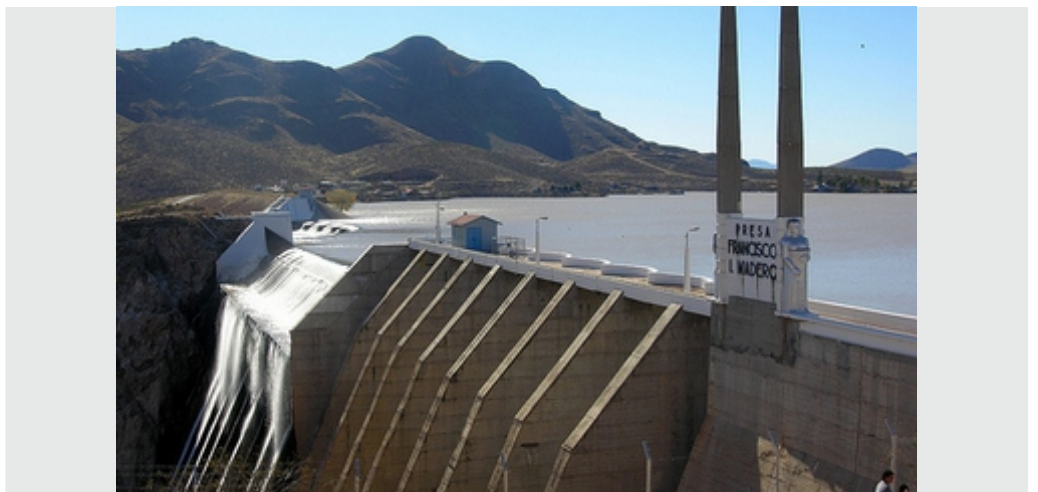
Presa La Boquilla
