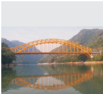
Vista del puente de boca del cerro en Tenosique sobre el majestuoso Río Usumacinta
