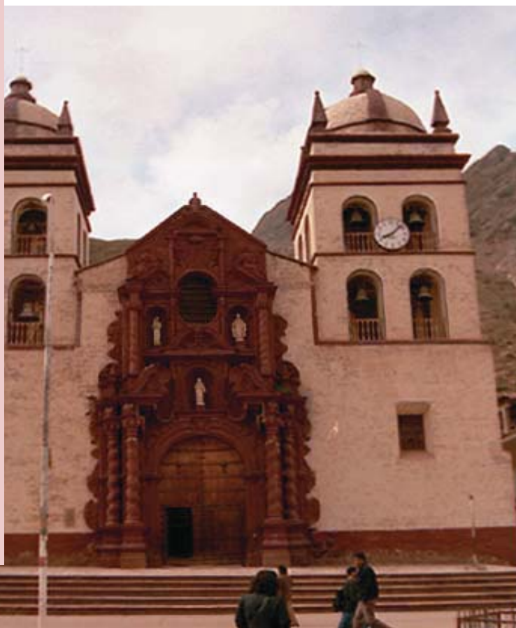
Arquitectura de Huancavelica
