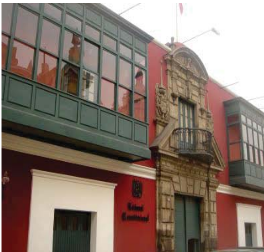
Edificio del Tribunal Constitucional, sede Lima.
