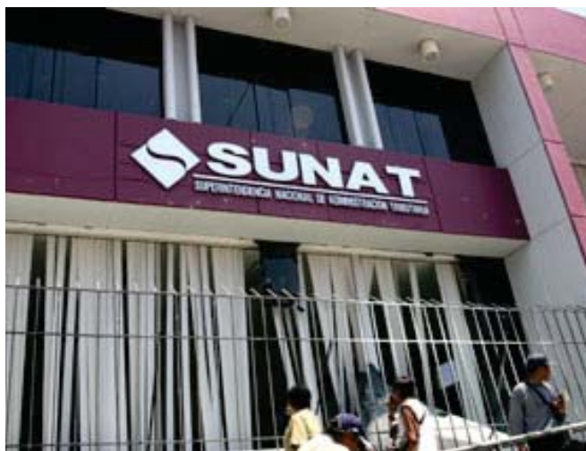
Edificio de SUNAT
